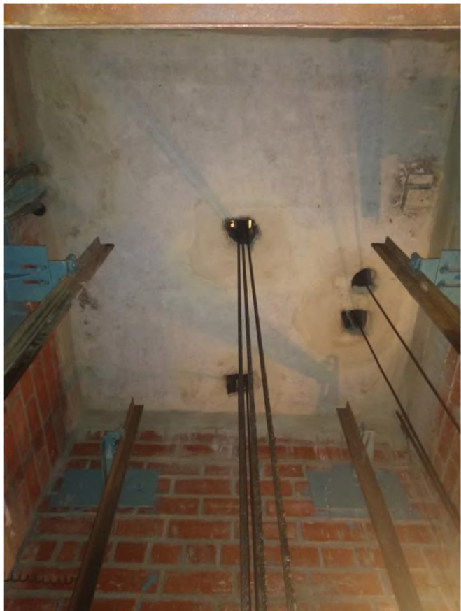
Рисунок 3 – Плита перекрытия шахты
