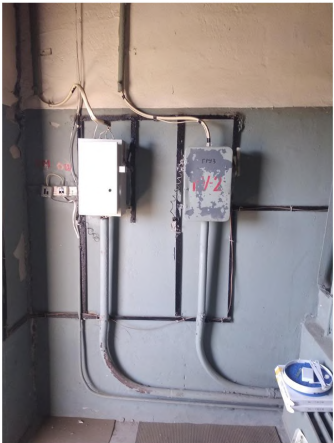
Рисунок 7 – Вводное устройство
