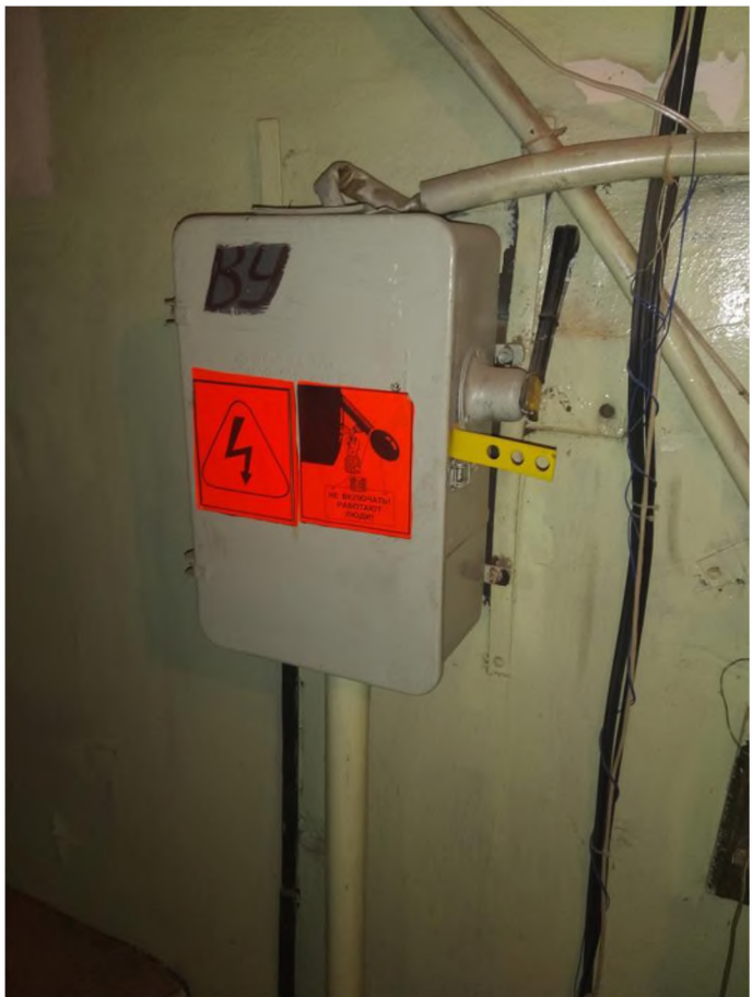
Рисунок 7 – Вводное устройство
